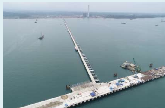
Konstruksi Dermaga Jetty Construction
