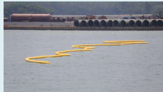
Pemasangan tirai lumpur Silt Curtain Installation
